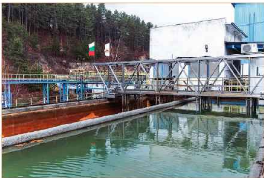
Като част от проекта за съвместната работа на пречиствателните станции за дренажни и руднични води е изграден стоманобетонен резервоар, с обем 10 хил. m 3 , в който постъпва водата от рудник „Асарел“
